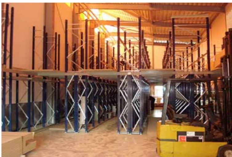
Fig. 4 - Scaffalature leggere con passerella.
