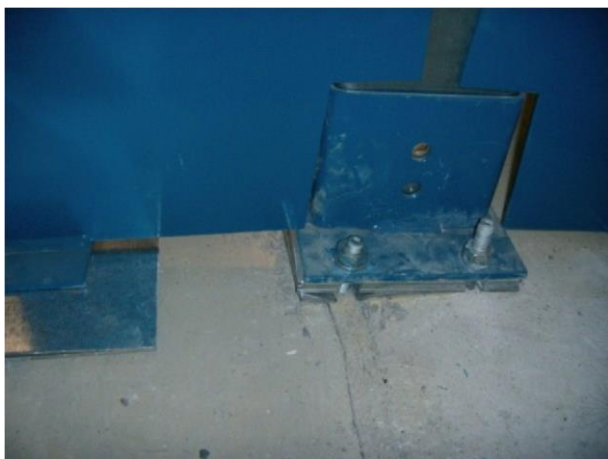
Figura 3 – Tassello installato su un giunto della pavimentazione
